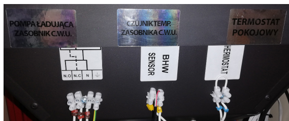
Zdjęcie listwy zaciskowej z tyłu urządzenia
