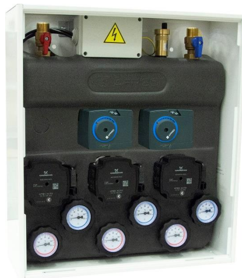
Rys. 1: Zestawy mieszające ze sprzęgłem hydraulicznym AZB
